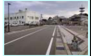
地区の南北分断を解消する道路の整備
