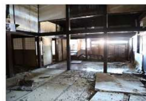
主屋シキダイ・タケノヤ 障子剥離、板・板戸破損等（南から）
