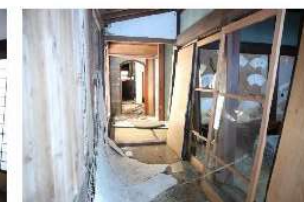
主屋エン 障子剥離、板戸・ガラス戸破損等（北西から）
