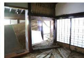
主屋サカサシキ 押板・脇床裏側、障子剥離等（南から）
