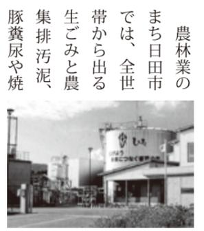
農林業のまち日田市では、全世帯から出る生ごみと農集排汚泥、豚糞尿や焼酎かすなど80トン/日をメタン発酵し、メタンガスを利用した発電を行っています。処理過程で発生する残さは、たい肥や液肥として地域の農家に提供しています。
