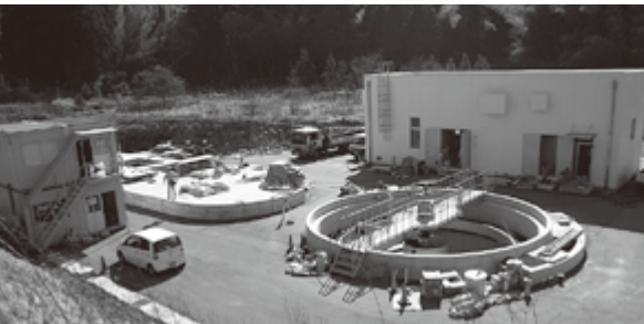
6月の供用開始に向け整備中の松波浄化センター
