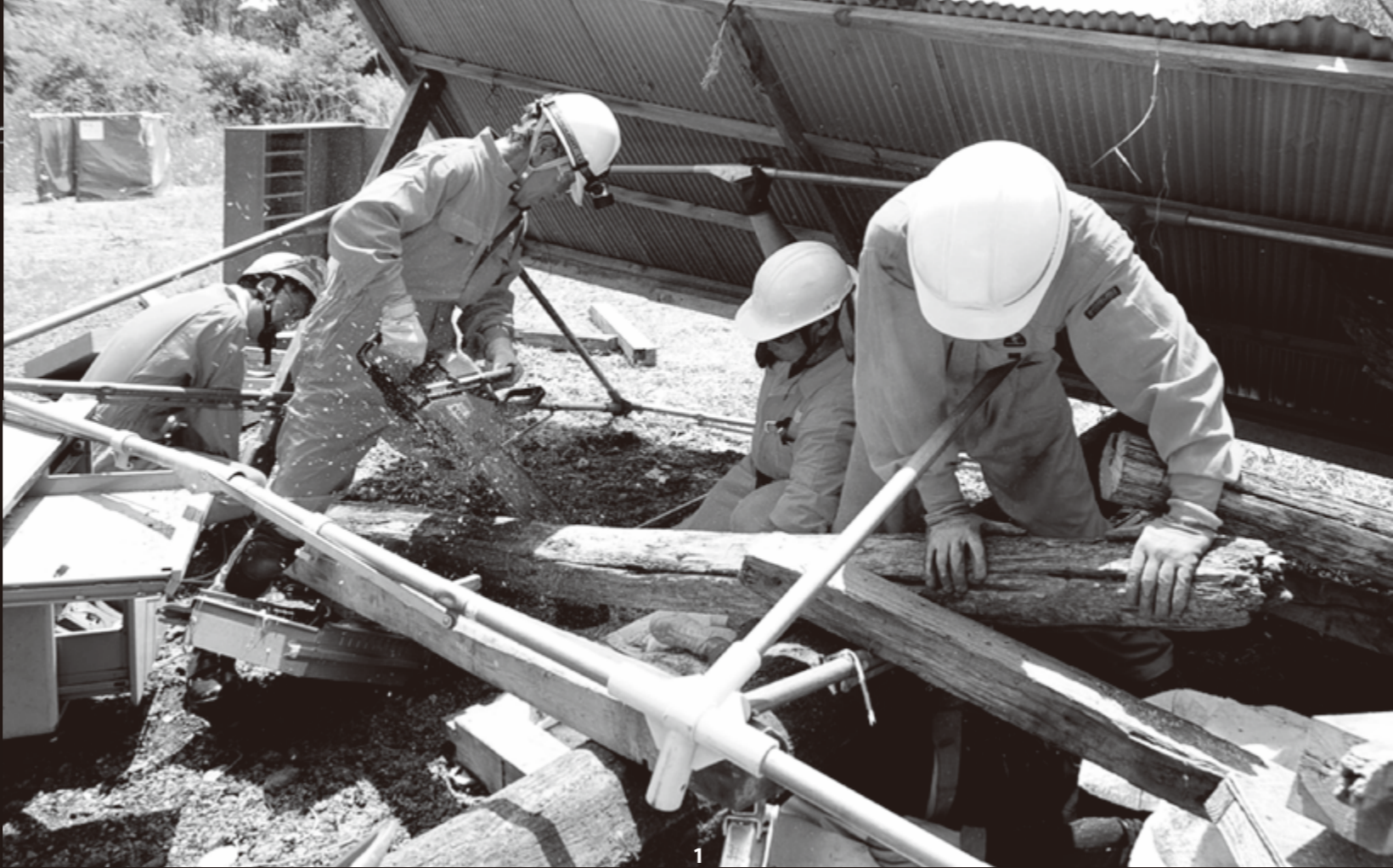
1_チェーンソーやジャッキを使って倒壊建物から住民を救助するレスキュー隊 / 2_リヤカーを再利用した「人力救急車」。自動車が通れない場所で負傷者、病人や寝たきりの人などを搬送する / 3_地区内の被害状況や安否を確認するバイク隊 / 4_炊き出しに必要な物資、食材や調味料はみんなが持ち寄った。手分けして80人分の食事を準備 / 5_復興水田「がんばっ田」の田植え / 6_被災者と一緒にホテルを鑑賞。神秘的な光が心をいやした
