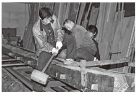
【木柱制作作業】直径 1 ㍎近い巨大木柱列の制作には、木造船製作の寄木技術が駆使された。地元真脇の元船大工、川端栄一さんの協力を受けて、こだわりの木柱列が完成した。
