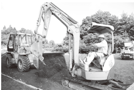
道路復旧訓練
