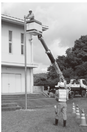
高所作業車での電気応急復旧訓練
