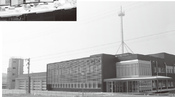
高機能消防指令センターが置かれる本部庁舎
