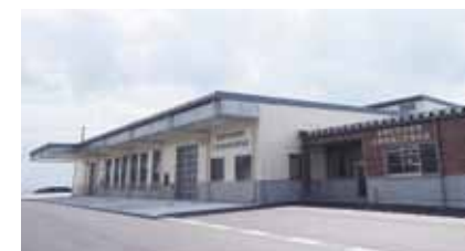
左側の建物が鮮度保持施設、右側は加工処理施設
