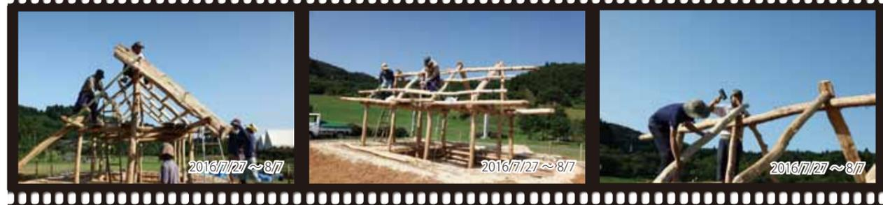
割製材で板になった破風板にホソ穴を空け、屋中と破風を調整しながら取り付ける
