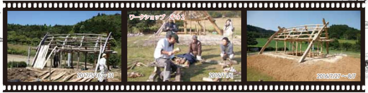
屋根仕上げ作業。クリ木の半割り材を立て並べ、クリ皮を敷く
