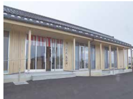
完成した内浦長尾集会所
