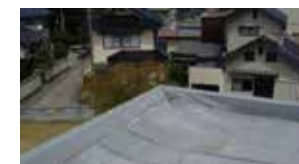
屋上の防水シートがめくれている状況（ひばり保育所：修繕済）
