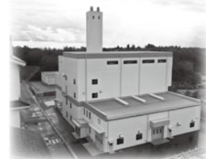
新たな施設は、令和2年7月に着工、本年1月から試運転を実施し、竣工を迎えました。1日12時間の稼働により15トンの可燃ゴミを処理できる炉を2基備え、処理の過程で発生する熱や廃水を施設内で処理・再利用するなど、周辺環境に配慮した施設となっています。
