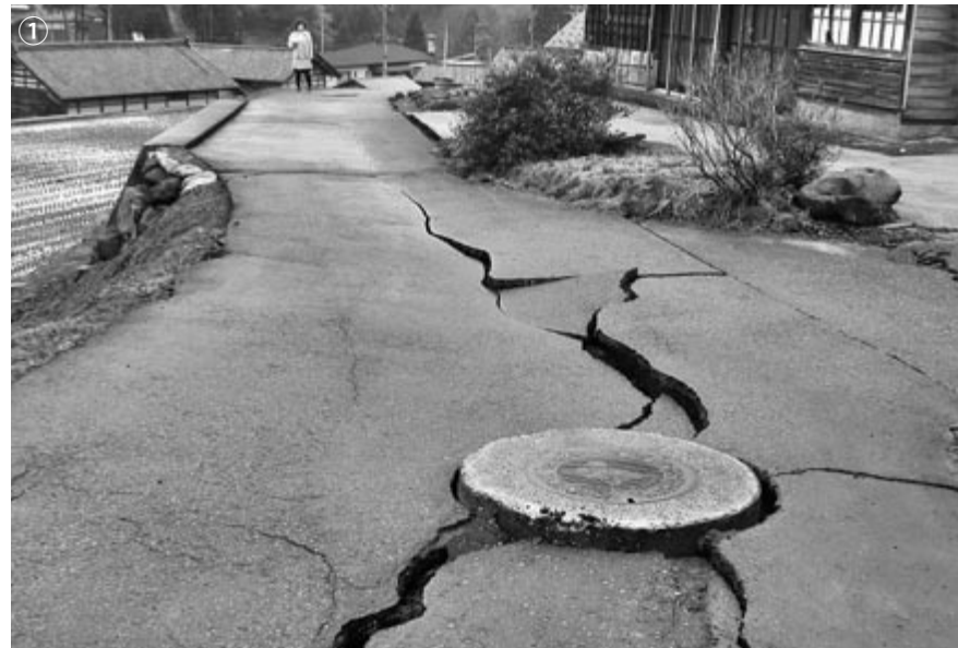
①黒川市内の町道、マンホール周りのアスファルトがひび割れた。 ②国重地内の農道、約50mにわたり道路が陥没した。 ③瑞穂公民館、2階の窓ガラスが割れ、破片が周囲に飛び散った。 ④今回の地震で全壊や半壊した家屋は、古い土蔵や納屋が多かった。 ⑤小木新港では岸壁横の埋立地が長さ100mにわたり陥没するなど港の被害も大きかった。
