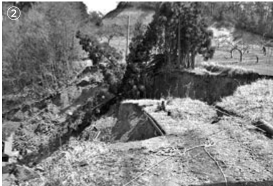
①黒川市内の町道、マンホール周りのアスファルトがひび割れた。 ②国重地内の農道、約50mにわたり道路が陥没した。 ③瑞穂公民館、2階の窓ガラスが割れ、破片が周囲に飛び散った。 ④今回の地震で全壊や半壊した家屋は、古い土蔵や納屋が多かった。 ⑤小木新港では岸壁横の埋立地が長さ100mにわたり陥没するなど港の被害も大きかった。
