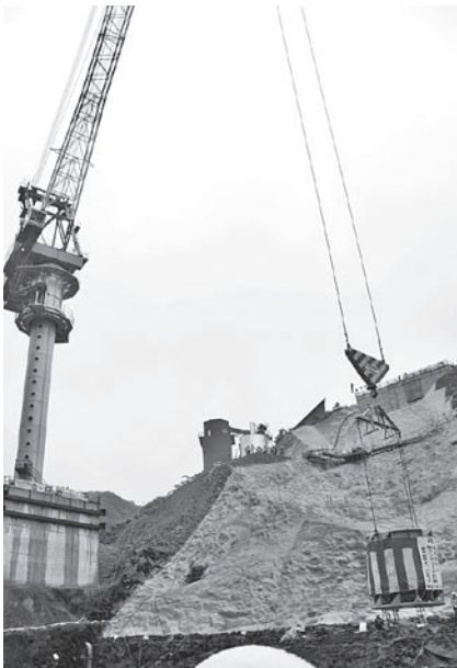
▲タワークレーンに吊られるバケットには、4.5㎡のコンクリート
