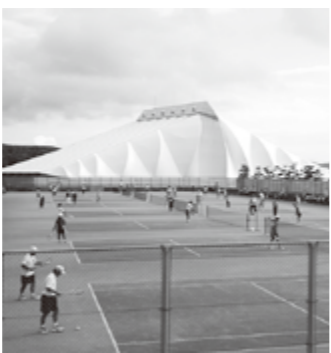
▽ テニスコート4面改修工事
