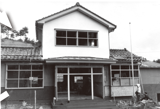
昭和40年に建てられた木造の園舎
