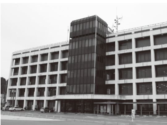
建築から43年経過し、老朽化が進む能都庁舎
