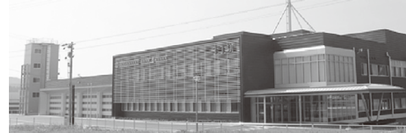
高機能消防指令センターが置かれる本部庁舎
