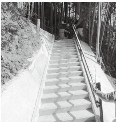
高台に続く津波避難路
