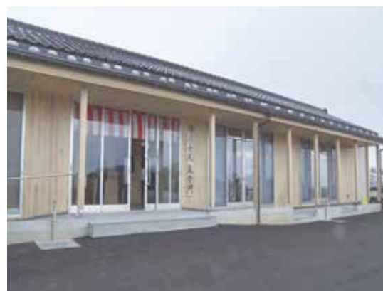
完成した内浦長尾集会所
