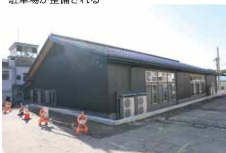
総合支所裏側、奥に見える柳田庁舎は解体され駐車場が整備される
