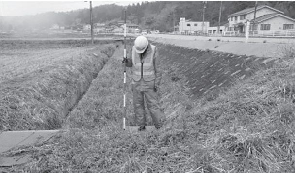
▲災害公営住宅整備事業「柳田団地（仮称）」測量の様子
