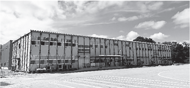
▲「松波小学校仮設校舎」令和6年9月2日供用開始
