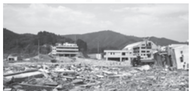
東日本大震災の被害状況
