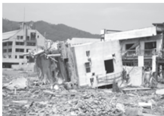
東日本大震災の被害状況
