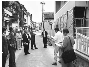
こどもみらいセンター耐震補強工事現場
