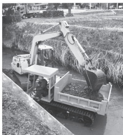
河川堆積土砂の除去作業
