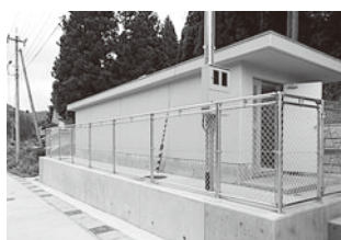
上町第2ポンプ場
