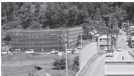
建設中の消防宇出津分署
