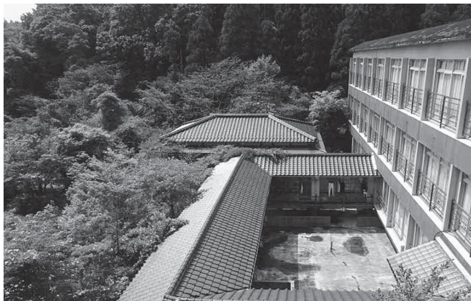
旧ホテルを取り壊し新設棟を建設
