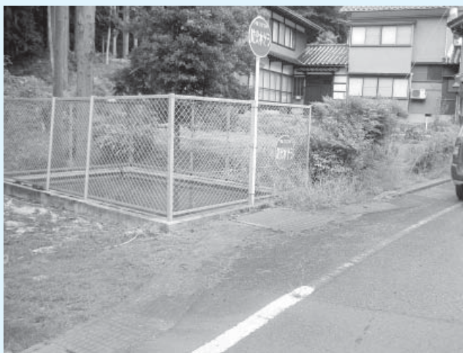
私有地に設置された防火水槽もあります
