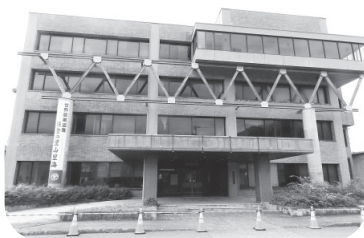
解体される旧内浦庁舎
