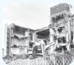
解体中の内浦庁舎
