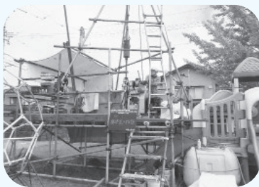
現地では地質調査が進んでいる
