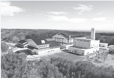
新焼却施設全景
