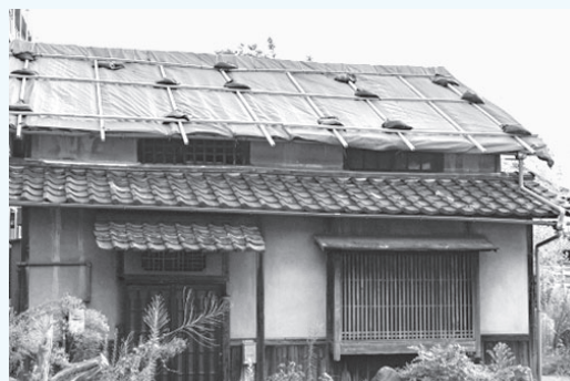
ブルーシートで応急処置した家屋（イメージ）
