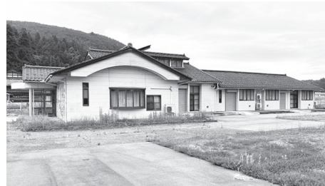
防災備蓄倉庫（旧上町保育所）
