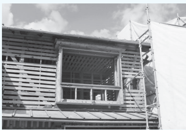
住宅の修繕工事（イメージ）
