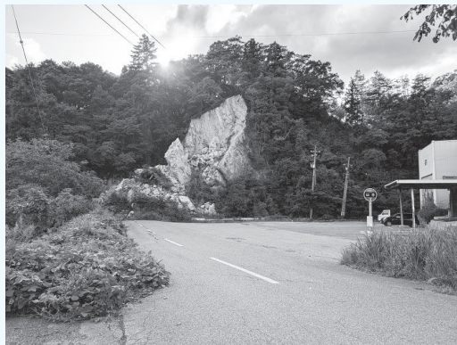
大規模な崩落で不通となっている宇出津第3トンネル
