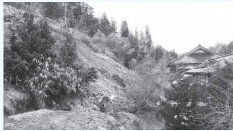
奥能登豪雨災害により林地が崩壊した現場
