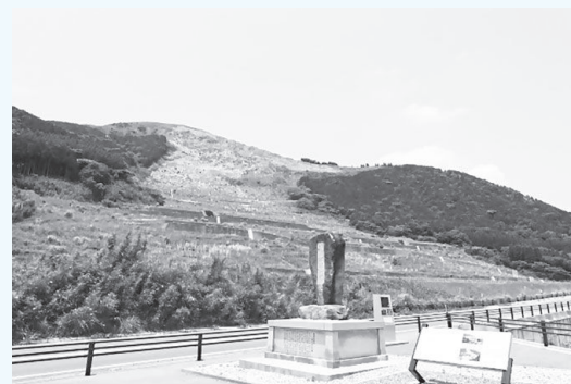
熊本地震で斜面崩壊となった数鹿流崩之碑
