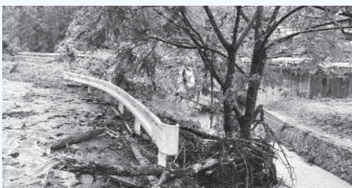
奥能登豪雨災害による被害
