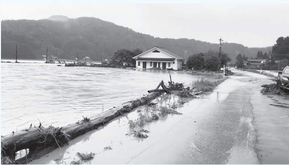
奥能登豪雨により被害を受けた河川と道路
