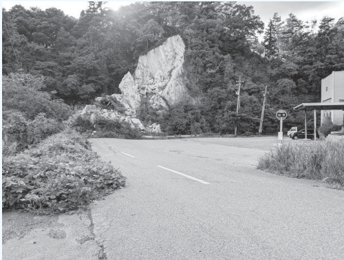
通行止めとなっている宇出津第3隧道
