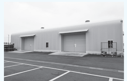
仮設卸市場（宇出津新港地内）
