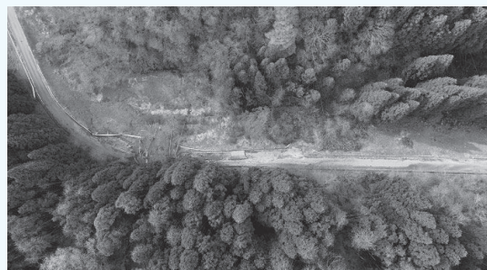
通行止めとなっている1級笹川宇出津1号線（久田地内）
