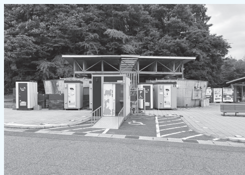
道の駅桜峠の仮設トイレ
