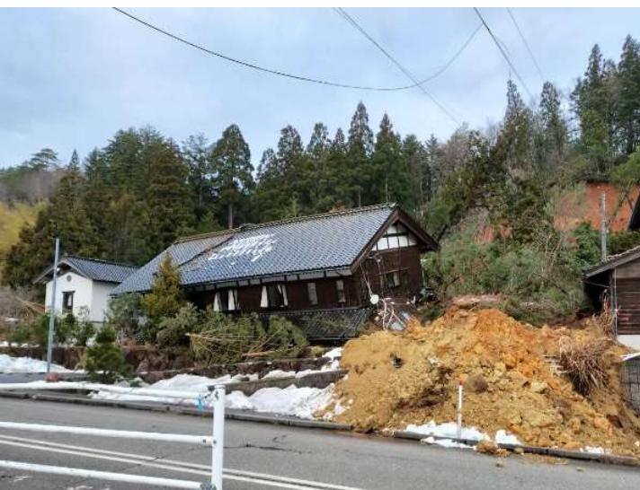
① 土砂崩れと家屋損壊
