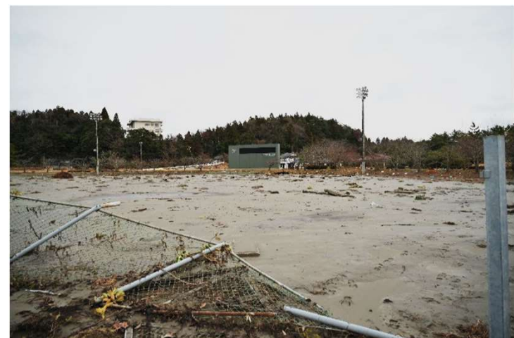
⑱ 津波被害を受けた内浦野球場
