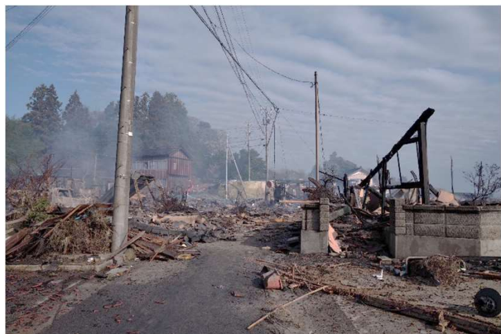
⑮ 津波と火災の跡
