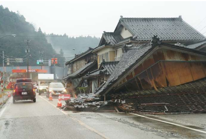
④ 家屋倒壊（国道249号線）
