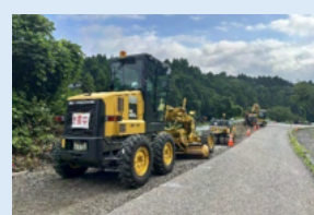
道路応急復旧工事
