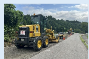
道路応急復旧工事
