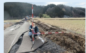
被災箇所測量
