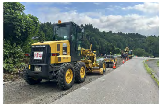
道路応急復旧工事
