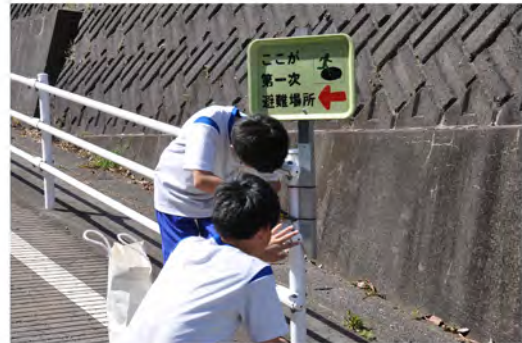
防災教育(小木中学校の避難誘導看板設置)
