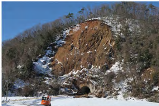
山腹崩壊（北河内トンネル）
